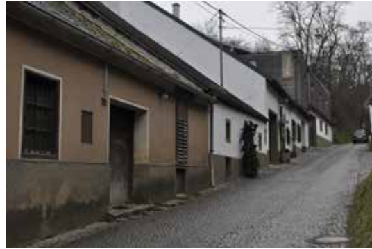
Abb. 26: Großer Buriweg in Langenlois
