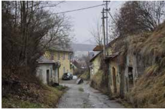
Abb. 30: Mittlerer Spiegelgraben in Langenlois
