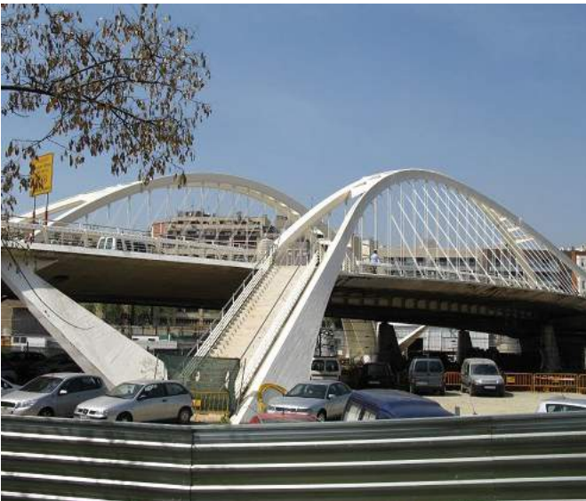
Abb. 155: Beispiel Brückenkonstruktion in Barcelona
