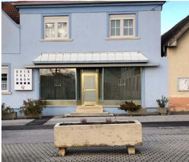
Abb. 87 Ehemalige Bar: Freiraum Erix. (Hof/L)
