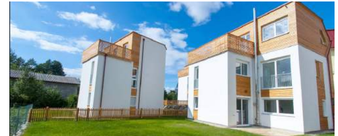
Abb. 177: Beispiel Flachbauten „Flair Green Village“ Mauerbach
