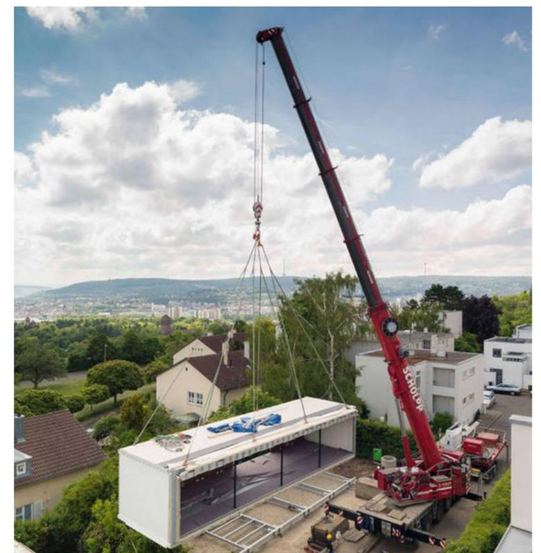
Abb. 24: Container -Einfache Errichtung
