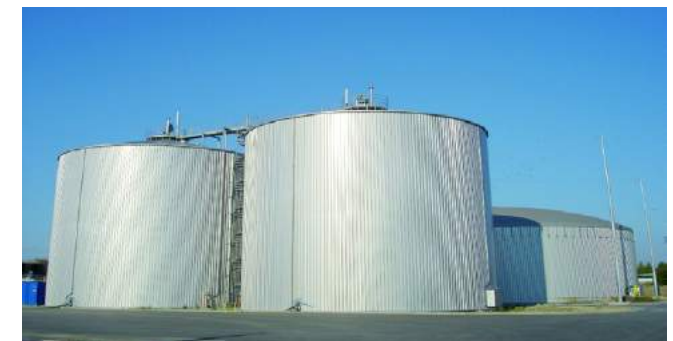
Abb. 92: Biogasanlage in Bruck an der Leitha
