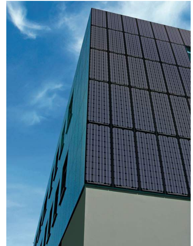
Abb. 188: Fassade mit Photovoltaikanlage
