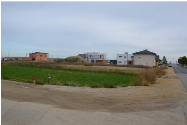
Abb. 26: Neubautätigkeit in Trautmannsdorf an der Leitha
