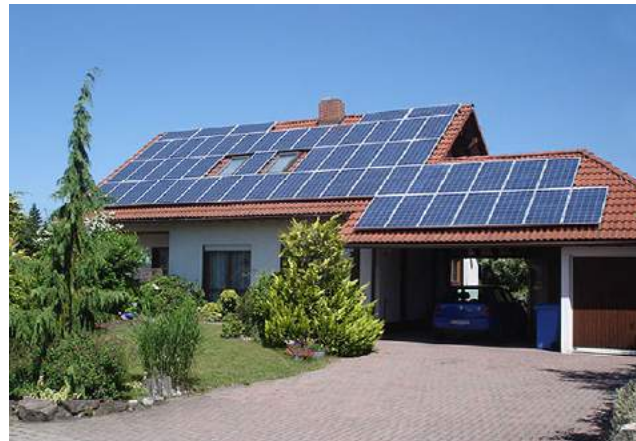
Abb. 187: Photovoltaikanlage auf einem Einfamilienhaus
