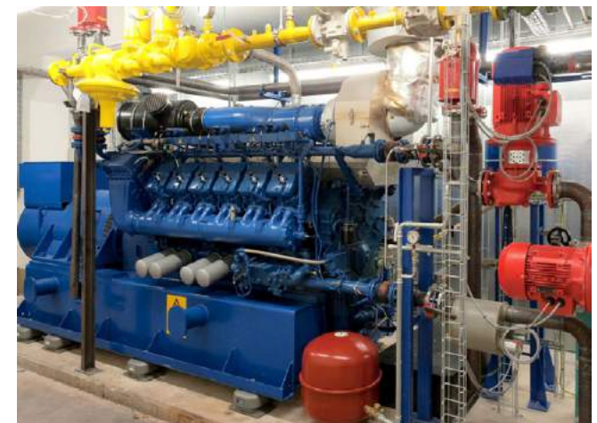
Abb. 152: Kraft-Wärme-Kopplungsanlage
