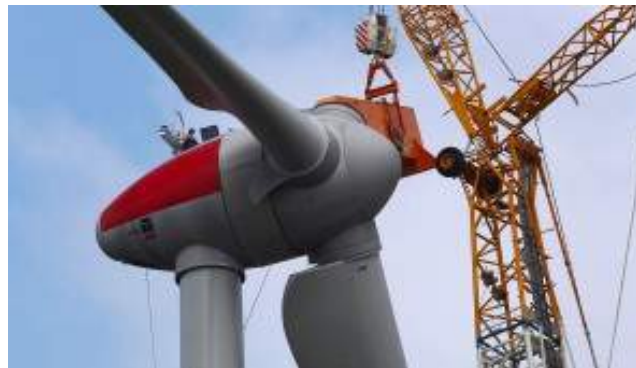
Abb. 193: Austausch eines Windradgetriebes
