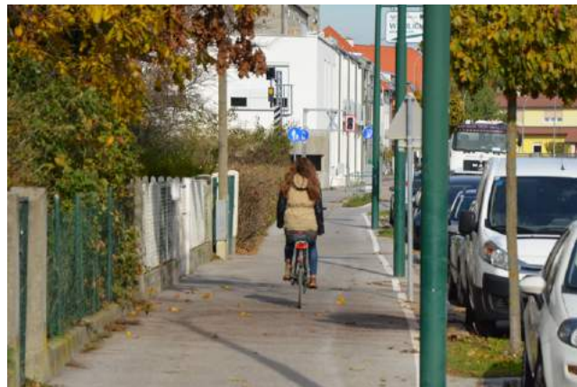
Abb. 78: Radweg in Bruck an der Leitha
