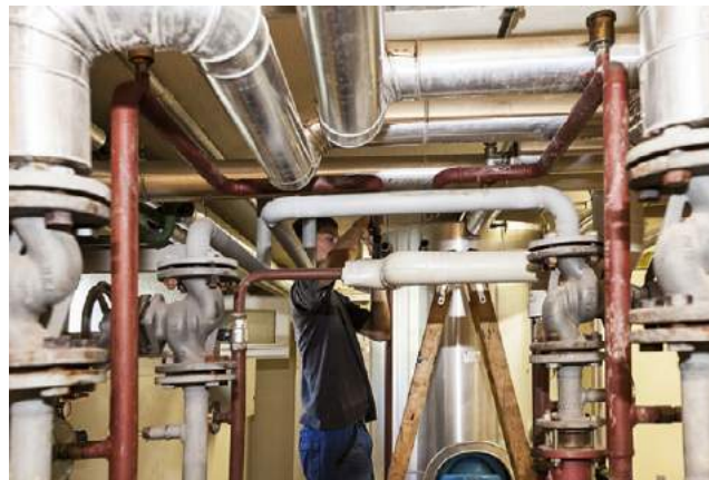
Abb. 194: Modernisierung einer Heizungsanlage
