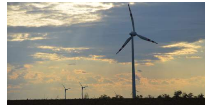
Abb. 94: Windkraftanlagen in Bruck an der Leitha
