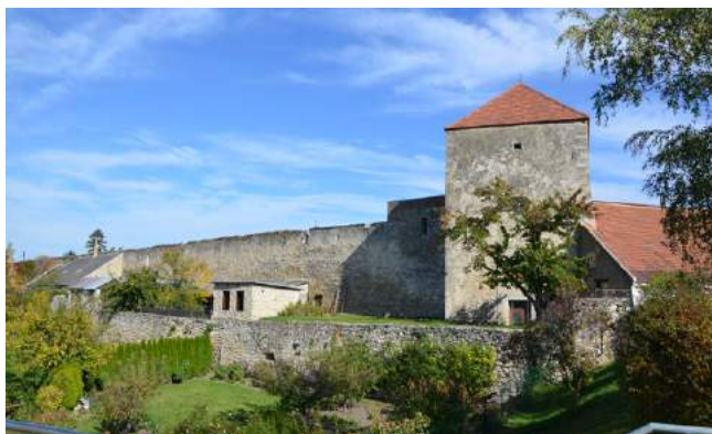
Abb. 17: Befestigungsanlage in Bruck an der Leitha
