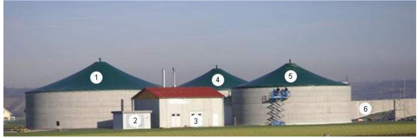
(1) Endlager (2) Trafostation (3) Heizhaus (4) Fermenter 1 (5) Fermenter 2 (6) Fahrsilo
