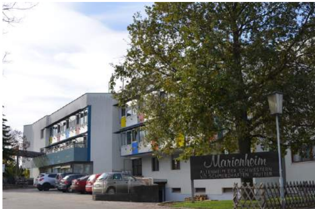
Abb. 97: Altenheim „Marionheim“ in Bruck an der Leitha
