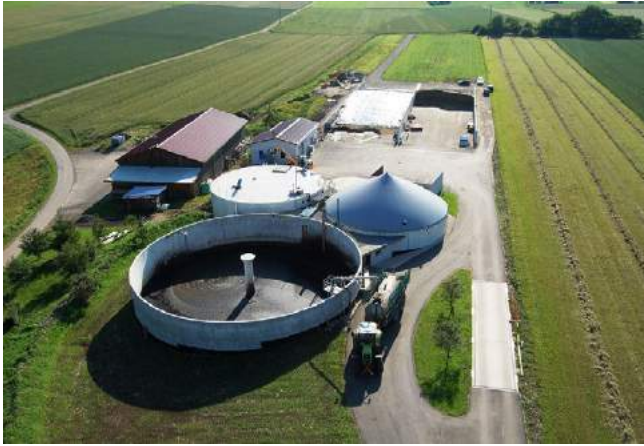
Abb. 185: Biogasanlage in Burladingen
