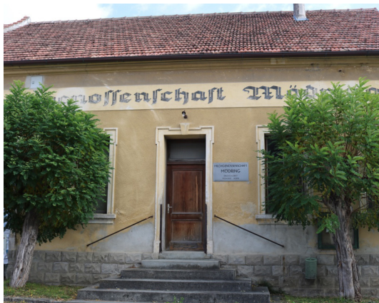
Abb. 1.27: Ungenutztes Gebäude der ehemaligen Milchgenossenschaft, eigene Aufnahme
