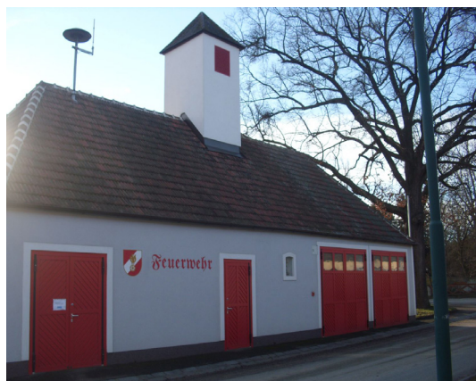
Abb. 1.35: Das 2009 renovierte Gebäude der Freiwilligen Feuerwehr, ff-muehlfeld.at
