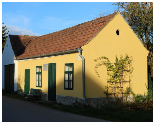
Abb. 1.33: Ehemaliges Haus der Milchgenossenschaft hinter der Kapelle, eigene Aufnahme
