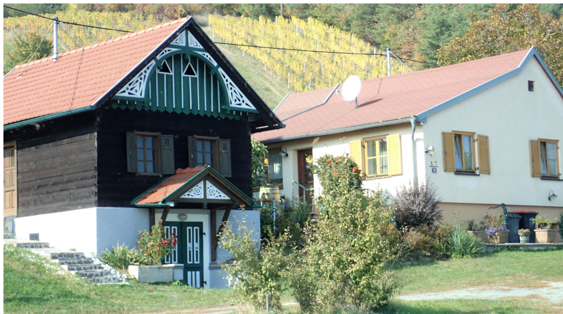
Abbildung 97: Kellerstöckl Alt- & Neubau. Aufnahme Fr. Dipl.-Ing. Drin. Gisa Ruland Eisenberg
