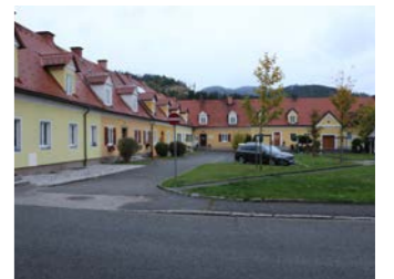
Abb. 2.14: Reihenhausiedlung Hafning. Quelle: Eigene Aufnahme vom 14.10.2020
