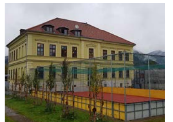
Abb. 2.23: Volksschule Trofaiach. Quelle: Eigene Aufnahme vom 13.10.2020
