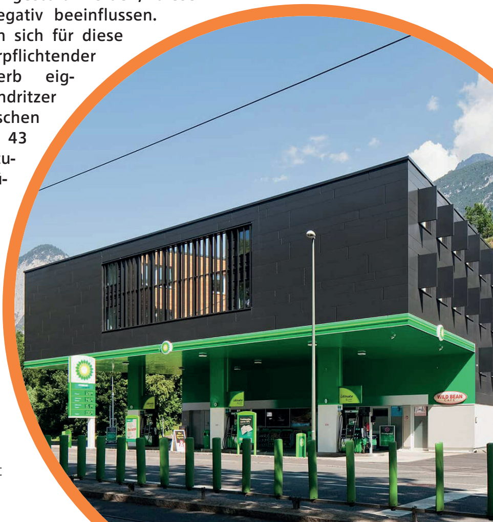
Abb. 116: Überbauung, Quelle: domico.at
